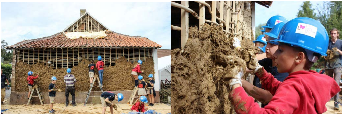
Jong Redt Oud-project 'Chiro Redt Vakwerk': herstellen van vits- en leemwerk
